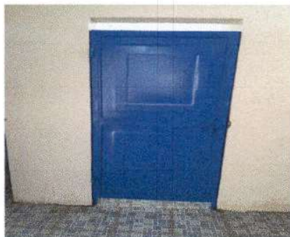
Foto 1: colocación de puertas internas
