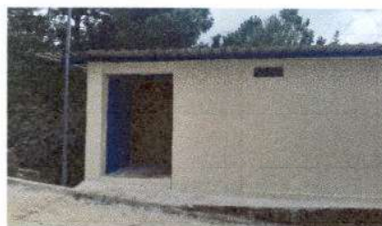
Foto 6: muro perimetrar en completa reparación
