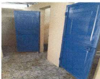
Foto 5: cernido en soleras internas y pintura
