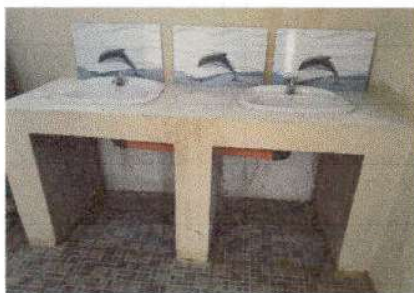
Foto 3: colocación y acabado en de lavamanos
