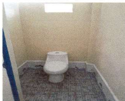
Foto 4: colocación de inodoros
