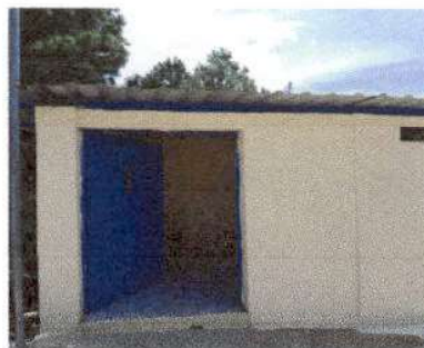
Foto 2: colocación de puerta principal
